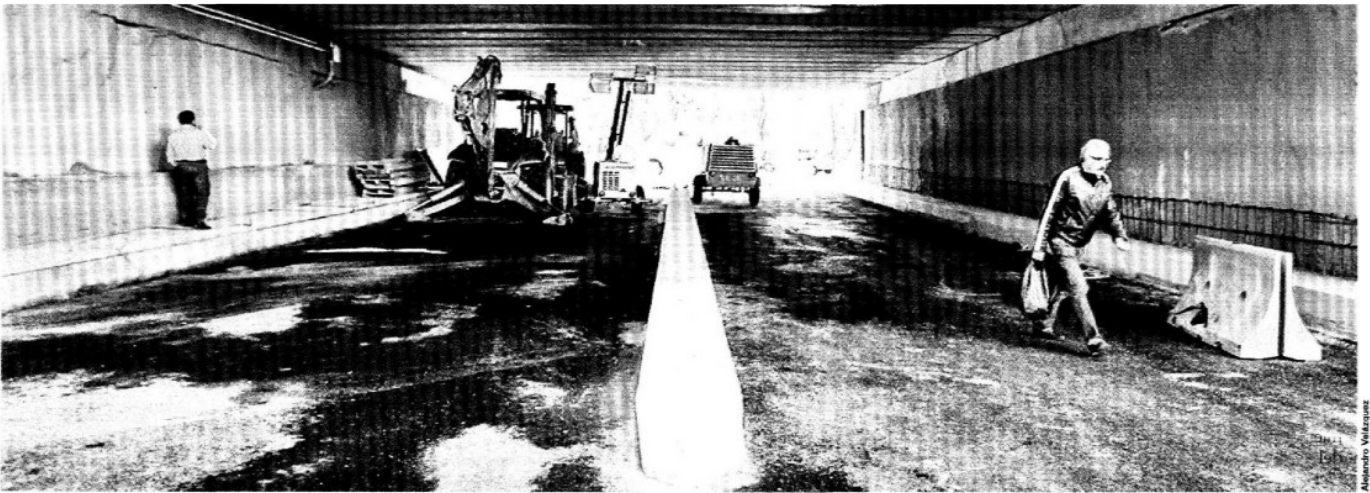
EN PAUSA. Durante un recorrido se observó que en el túnel de Echegaray hay dos retroexcavadoras y material de construcción, pero no trabajadores.
