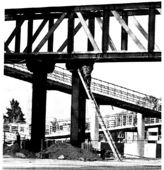
> Trabajadores aún laboran en el detallado de puentes.
