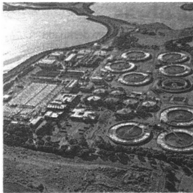
PLANTA DE TRATAMIENTO DE AGUAS EN ATOTONILCO
