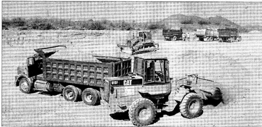
»» LOS TRABAJOS de construcción de los rellenos sanitarios ya dieron inicio.
