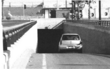
Paso a desnivel
