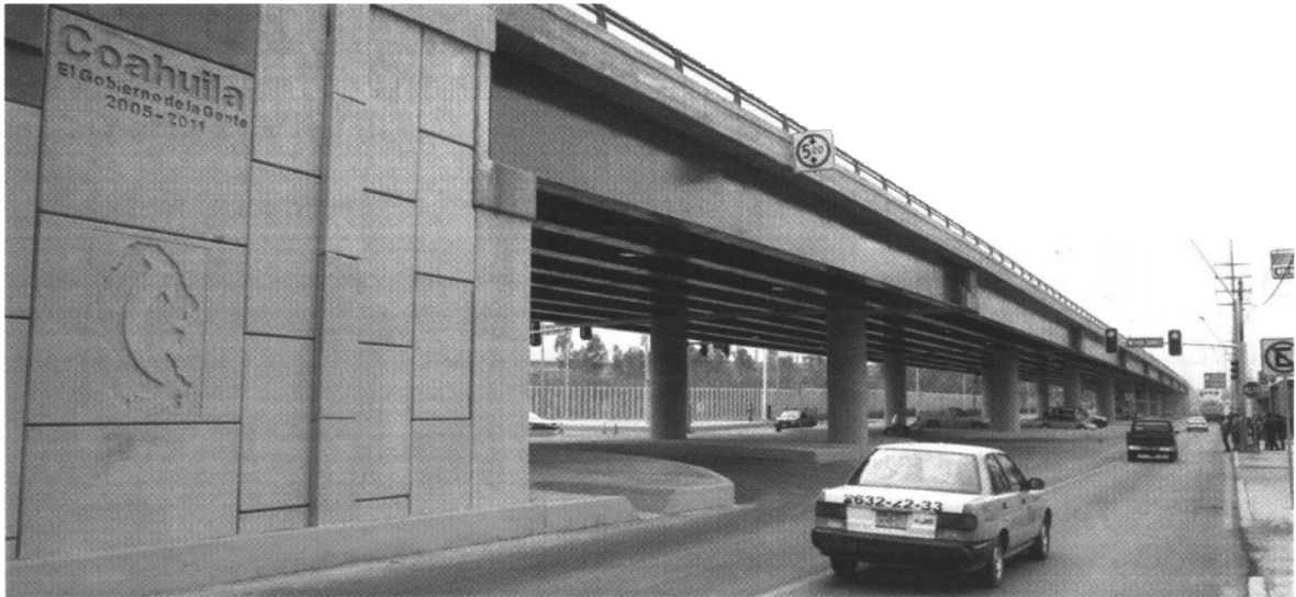
Puente Pape y Av. Industrial
