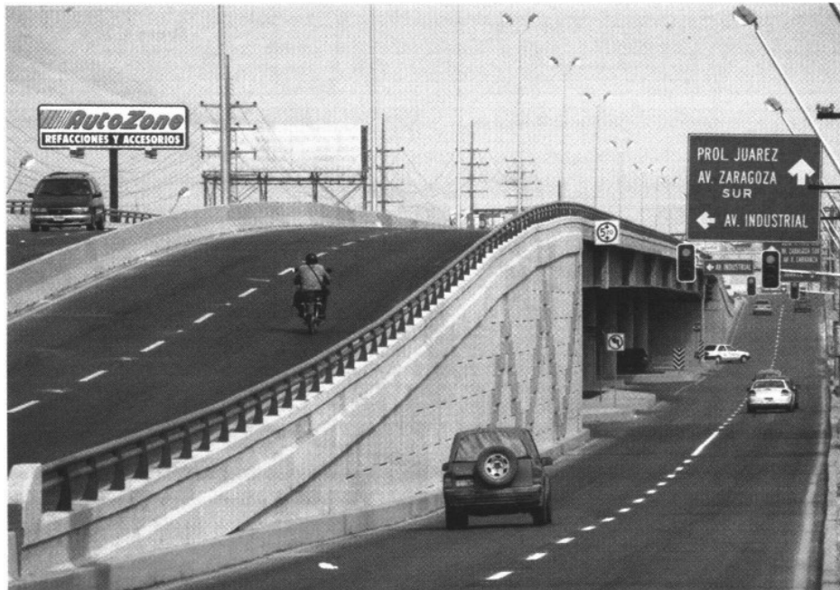
Puente Pape y Av. Industrial
