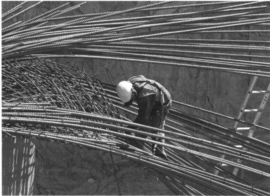
Construcción de puentes
