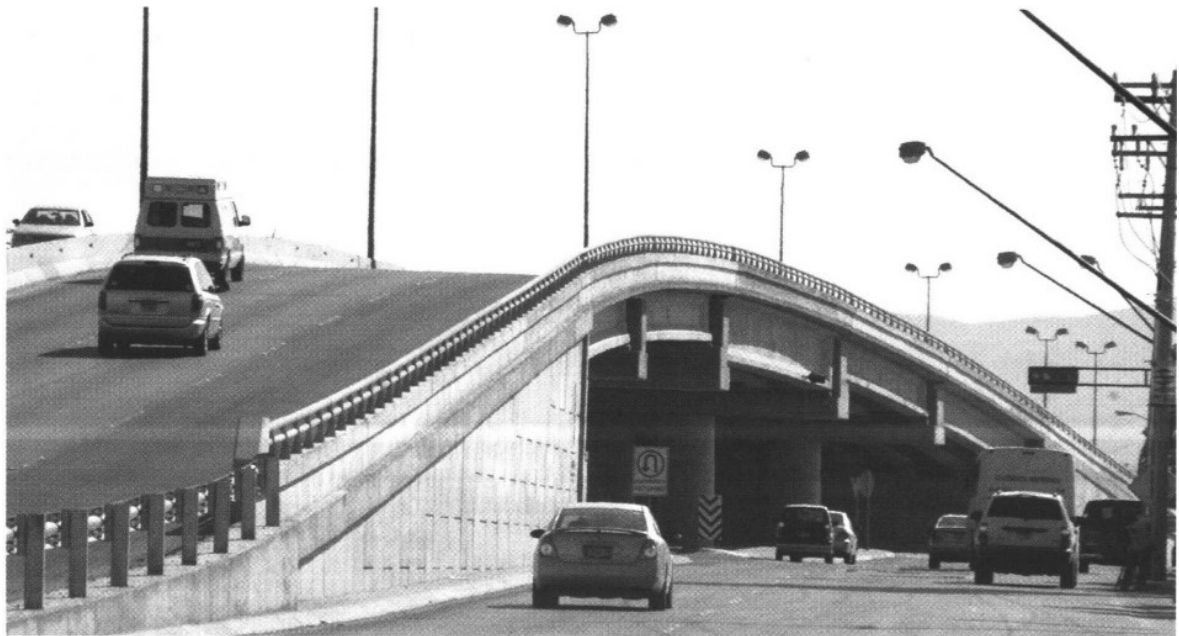
Viaducto Sistema Vial Alianza
