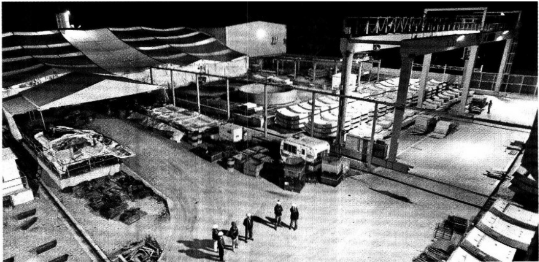
> A las 22:30 horas las actividades en la planta de dovelas de Zumpango se mantenía al cien por ciento. En la foto, personal de la Conagua supervisa la colocación de los anillos en el patio.
