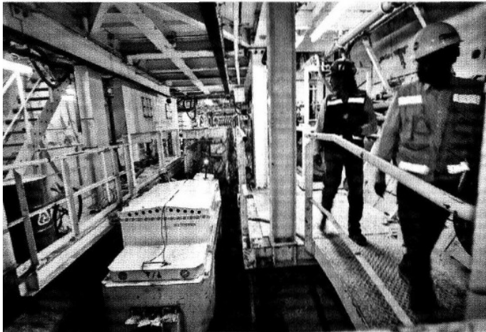
► Mientras afuera avanzaba la noche, abajo en el túnel la actividad seguía a todo vapor con el trabajo de la excavadora.
