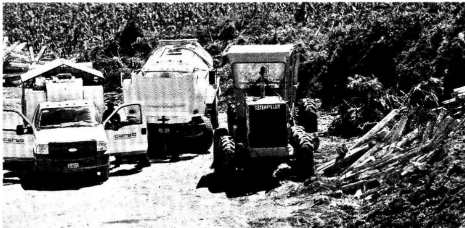
► La maquinaria está repartida a lo largo de la vía que conectará a Toluca con Ixtapan de la Sal.
