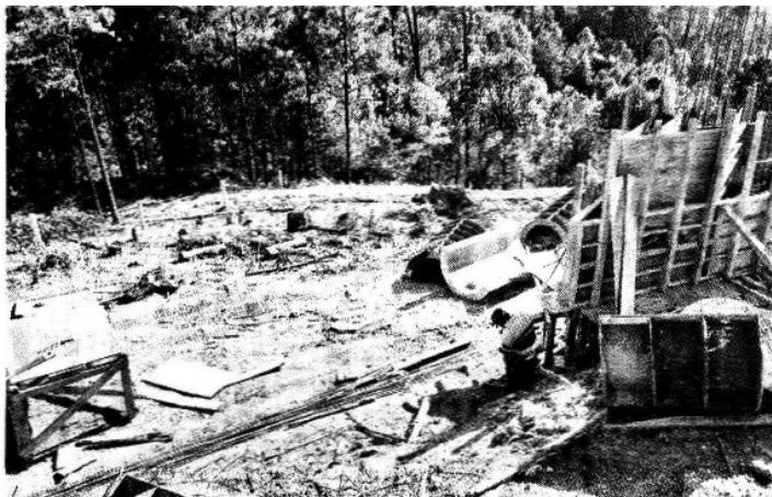
> En la Toluca-Zitácuaro, en Amanalco, abren paso a la carretera.
