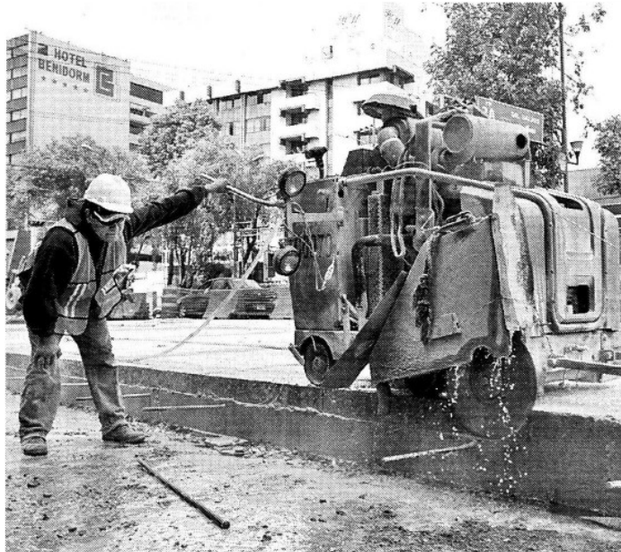
Demandan prontitud en la conclusión de las obras
