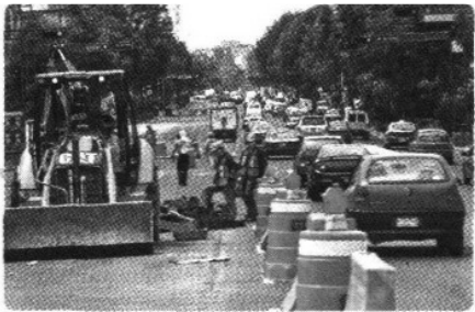
Zona de obras Está en marcha un proceso de transformación de la infraestructura vial en la ciudad para eficientar la movilidad de personas y bienes de manera segura.
