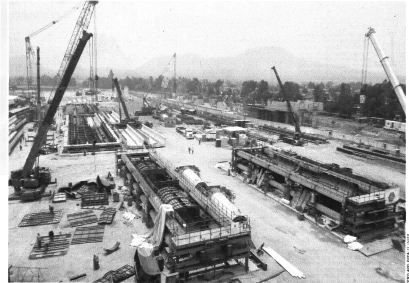
PLANTA MÓVIL. Ocho mesas de trabajo están dispuestas en la zona para fabricar traveses, columnas y ballenas. Todo puede trasladarse a otro sitio de obra
