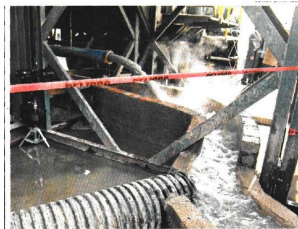
Diputado alerta que con recorte se afectará el sistema de agua potable.
