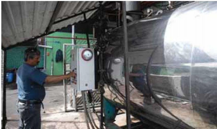
**Biodigestores.** Alimentan calderas industriales con biogás producido con desechos de [aguacate](#). / CONTRALUZ
